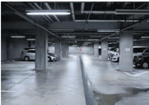
ホテル地下駐車場
