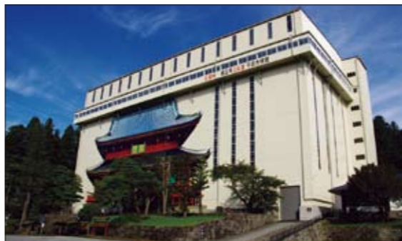
半解体修理の様子を工事期間中に限り回廊から見る事ができる。
