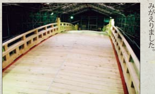
神橋の保存修理 木部組立(平成12年度)
