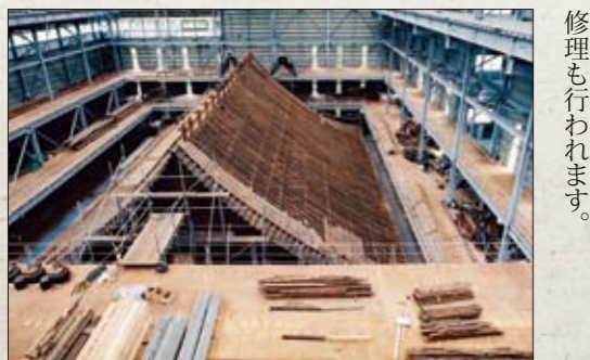
三仏堂の保存修理 素屋根建設・屋根野地解体(平成24年度)
