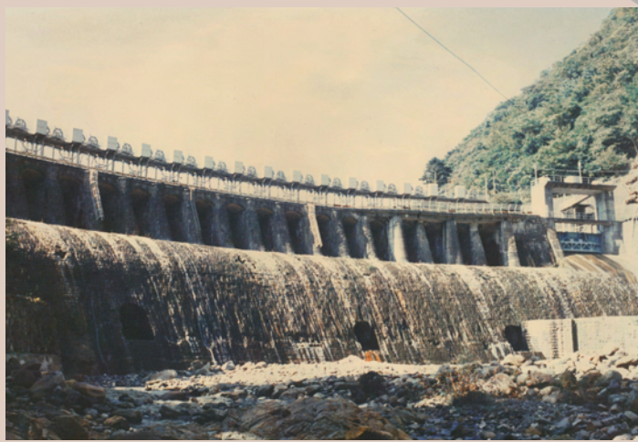
改修工事前の黒部ダム(昭和60年ごろ)
