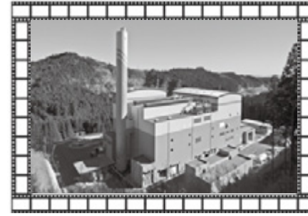
②クリーンセンター竣工(H22, 7)
