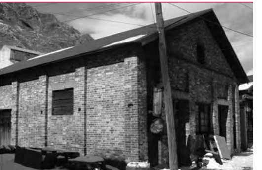
① 古河鉱業 間藤工場
