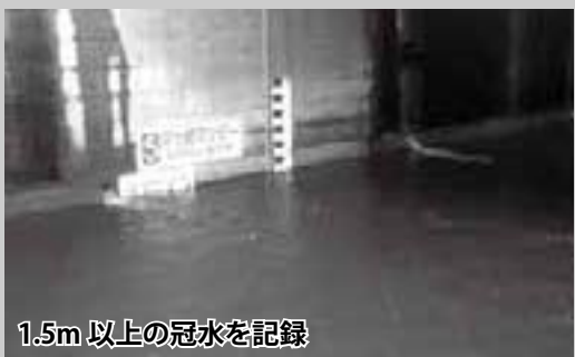
大雨で冠水した平ヶ崎アンダー
