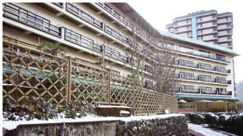
▲溪谷側に自然素材の垣を設けている例
