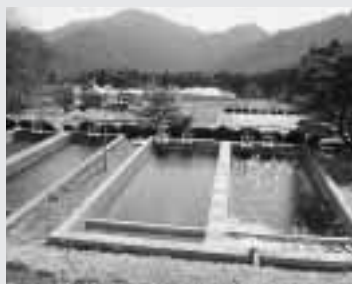
日光上水道施設整備事業 日光上水道給水区域に 安全な飲料水を供給する ために、安良沢浄水場の 改良工事を行います。
