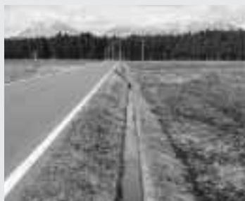
県営圃場整備事業 整形された農地と整備された農道や水路。農作業が効率的になり、また、道路が整備されることによって市民の生活の利便性も向上します。
