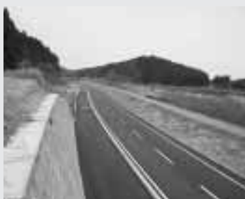
地域再生基盤強化交付金事業 地域再生基盤強化交付金（国庫補助金）を活用し、地域再生に資する市道の整備を行います。
