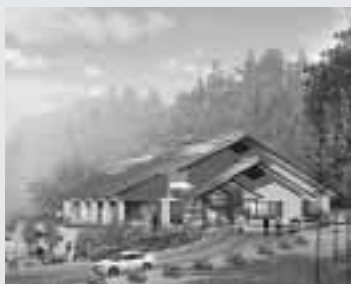
湯西川ダム水源地域整備事業・公民館整備事業 湯西川公民館を整備します。平成21年10月に完成予定です。
