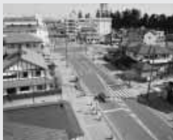
駅間ＪＲ今市土地区画整理事業 区画整理を実施した ＪＲ今市駅前の様子です。
