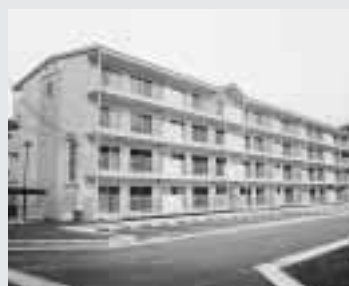
倉ヶ崎住宅建設事業 昨年11月に完成した、倉ヶ崎住宅2号棟です。
