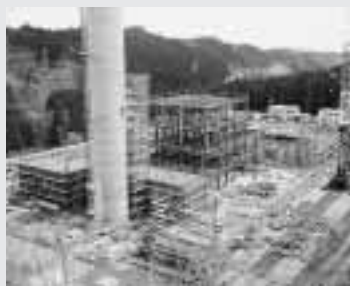
クリーンセンター建設事業 平成22年度の施設稼動開始に向け、現在建設中です。
