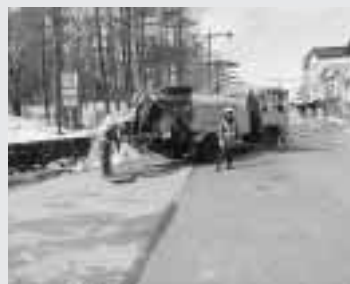
下水道維持管理費 下水管を維持保全する ための管路清掃を行っている様子です。
