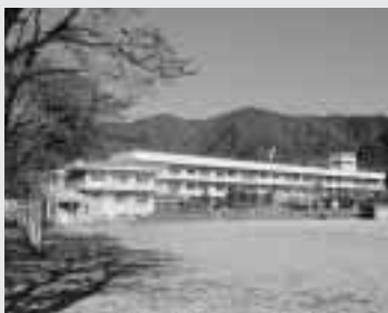
藤原中学校建設事業 藤原中学校の建替えを行います。来年度の完成を予定しています。
