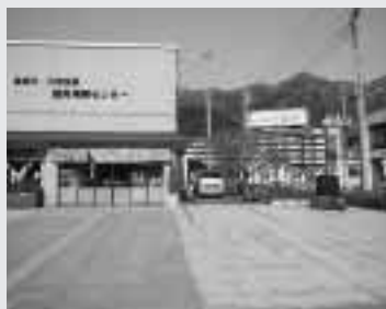
鬼怒川温泉駅前公衆トイレ整備事業 鬼怒川温泉駅前にある鬼怒川・川治温泉観光情報センター横に公衆トイレを整備します。
