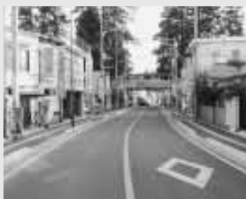
道路修築費 段差を無くし、安全・安心な歩道に改修すると共に、傷んだ車道の舗装を直します。
