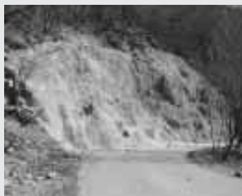
治山林道事業 林道の改良により林業生産基盤の整備を図ります。写真は昨年度実施した林道舟石線（足尾地域）の法面改良工事の状況です。
