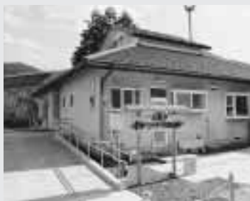
高齢者福祉施設整備事業 平成20年度にオープンした、小来川デイサービスセンターです。介護予防教室も開催しています。
