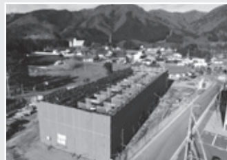
大原住宅建設事業費 大原市営住宅5号棟の整備中の様子です。
