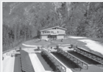
下水道維持管理費 湯西川水処理センター全景です。
