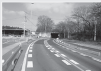
地方創生道整備推進交付金事業費 平成28年度に完成した市道 本町～猪倉線です。
