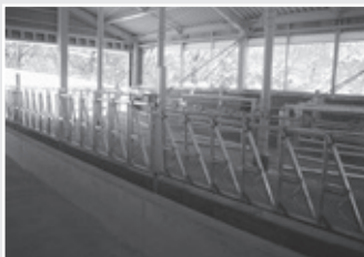
畜産担い手育成総合整備事業費 平成28年度に整備した牛舎の内部の様子です。
