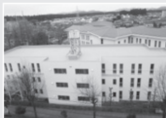
小学校校舎等維持管理費 平成28年度に外壁改修と屋根防水工事を行った、今市第三小学校の様子です。
