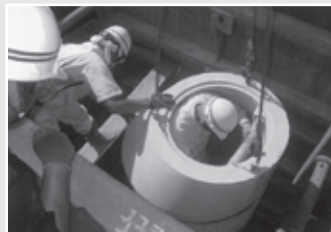
公共下水道建設事業費 針貝地内（今市地域）のマンホール設置の様子です。
