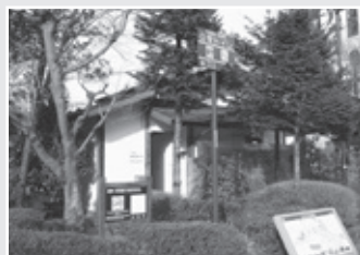
トイレ施設等維持管理費 平成28年度に洋式化等改修工事を実施した上鉢石公衆トイレです。
