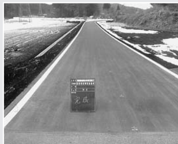
県単農業農村整備事業費 木和田島地内（今市地 域）に開設した農業用道 路です。
