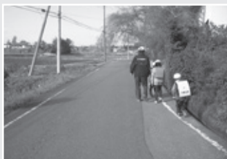
社会資本整備総合交付金（道路）事業費 平成28年度に整備する大室～萱場線の現在の様子です。
