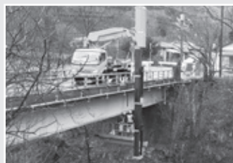
橋りょう維持補修費 市道に架かる橋の安全点検の様子です。橋りょうの安全確保を図ります。
