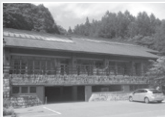
日光EV・PHVのまち推進事業費 非常時用分散電源システムが構築される湯西川地区センターの写真です。
