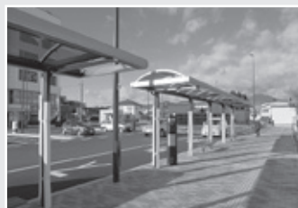
中心市街地活性化事業費 平成26年度から着手し、平成28年3月に完成した東武下今市駅前広場です。整備面積は約3,000㎡、周辺には、駐車場、ふれあい広場、公衆トイレ、駐輪場が整備されています。
