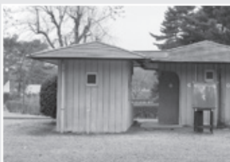
社会資本整備総合交付金（都市公園等）事業費 丸山公園の公衆トイレです。都市公園長寿命化計画に基づき、平成28年度、改築工事を行います。
