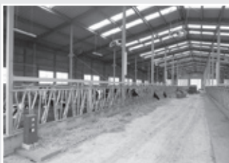
畜産担い手育成総合整備事業費 平成27年度に整備した牛舎の内部の様子です。
