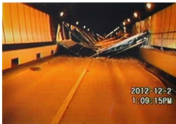
2012.12.2 中央道笹子トンネル 天井板崩落 9名死亡
