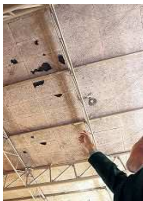
2012.11.25 輪島市上野台中体育館 天井崩落
