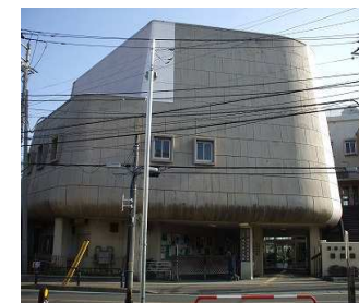
昭和41年建築の 大久保公民館・市民会館
