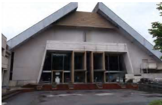
日光総合会館(昭和47年築)
