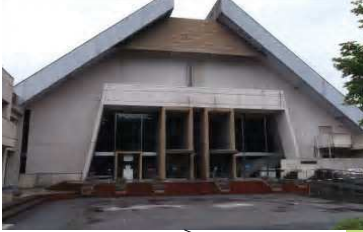
日光総合会館(昭和47年築)
