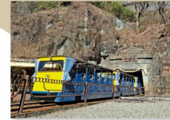
Entrada al túnel
