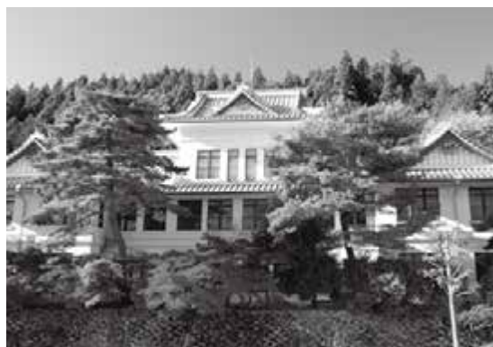
旧日光市庁舎本館(現在は修理中)
