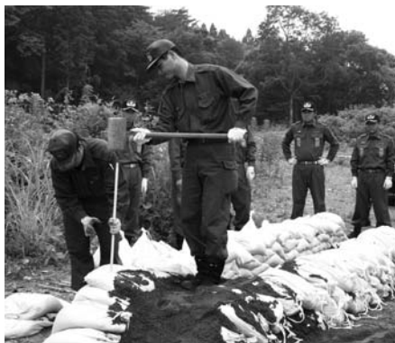
積み上げた土のうを杭で固定する団員
