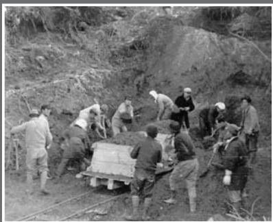
土砂崩れに巻き込まれた被害者救出の様子（平ヶ崎）。すべて手作業だったため、救出は困難を極めた。
