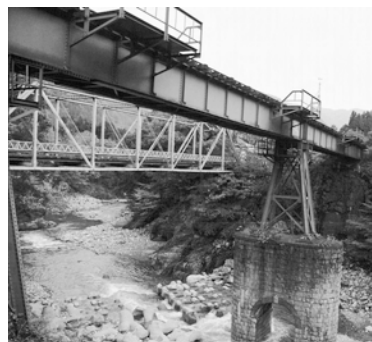
第一松木川橋梁
