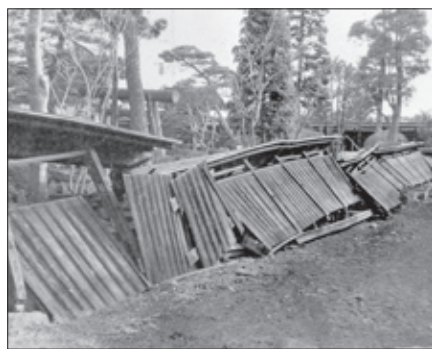
倒壊した滝尾神社付近の板塀
