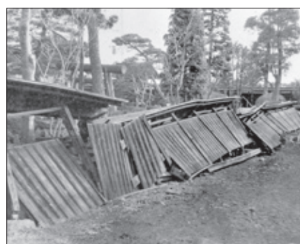
倒壊した滝尾神社付近の板塀
