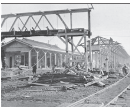
崩落した今市駅の設備
