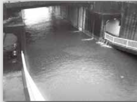
冠水時の平ヶ崎アンダー
