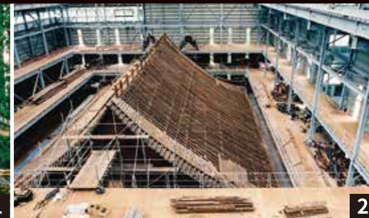
1. 東西透塀、唐门的保存修缮竣工（2011年度） 2. 三佛堂的保存修缮 素屋根（脚手架）搭建、屋顶野地拆解（2012年度） 3. 神桥的保存修缮 组装木头部分（2000年度）
