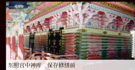
东照宫中神库 保存修缮前
