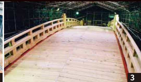
1. 東西透塀、唐门的保存修缮竣工（2011年度） 2. 三佛堂的保存修缮 素屋根（脚手架）搭建、屋顶野地拆解（2012年度） 3. 神桥的保存修缮 组装木头部分（2000年度）
