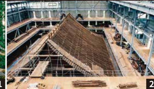
1. 東西透塀、唐門保存修理竣工(2011 年度) 2. 三佛堂的保存修理 素屋根(鷹架屋)搭建、屋頂野地解體(2012 年度) 3. 神橋的保存修理 木質部分組裝(2000 年度)
