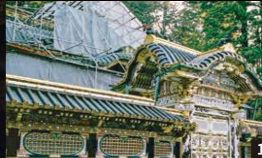
1. 東西透塀、唐門保存修理竣工(2011 年度) 2. 三佛堂的保存修理 素屋根(鷹架屋)搭建、屋頂野地解體(2012 年度) 3. 神橋的保存修理 木質部分組裝(2000 年度)
