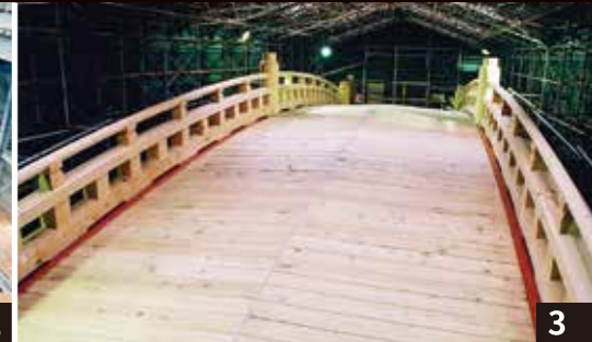
1. 東西透塀、唐門保存修理竣工(2011 年度) 2. 三佛堂的保存修理 素屋根(鷹架屋)搭建、屋頂野地解體(2012 年度) 3. 神橋的保存修理 木質部分組裝(2000 年度)
