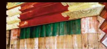
Mittlerer heiliger Speicher des Toshogu Schreins: Die Struktur und die Bemalung, die auf der Rückseite des Querholzes des Wandmaterials erhalten sind, beweisen, dass es sich um den Originalbau des Toshosha Schreins von Shogun Hidetada handelt. Dies haben Untersuchungen während der Restaurierung ergeben.
