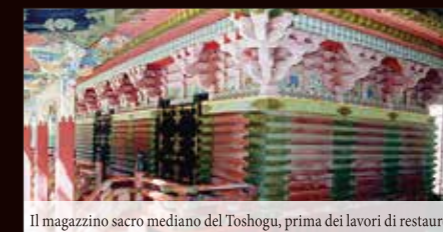
Il magazzino sacro mediano del Toshogu, prima dei lavori di restauro
