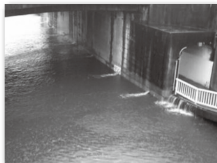
冠水時の平ヶ崎アンダー 高さ約1.5メートルの冠水となることも
