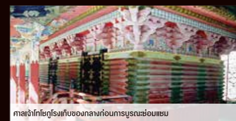
ศาลเจ้าโทกูโรงเก็บของกลางก่อนการบูรณะซ่อมแซม
