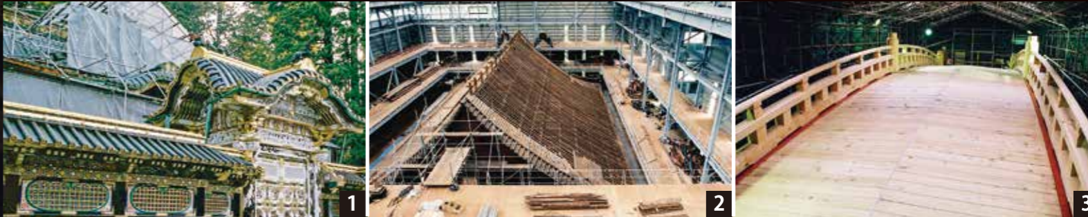
1. การดำเนินงานบูรณะซ่อมแซมประตูระตะระ เน และรั้วล้อมรอบตั้งบูรพาและประจิม (ปีเตอร์ 13) 2. การดำเนินงานบูรณะซ่อมแซมวิหารชินบูตซุจิ, ผนังหลังคาและหลังคาชั้นนอก (ปีเตอร์ 24) 3. การดำเนินงานบูรณะซ่อมแซมสะพานชินเกียวส่วนที่เป็นไม้ (ปีเตอร์ 12)
