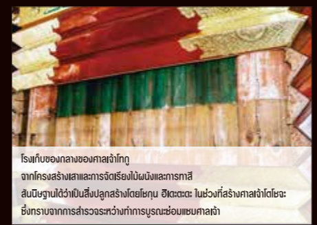
โรงเก็บของกลางของศาลเจ้าโทกู จากโครงสร้างและอาคารจัดเรียงไม้ฉางและการทาสี สืบมรดกไว้ว่าเป็นสิ่งปลูกสร้างโดยโชกุน อิเตตะระ ในช่วงที่สร้างศาลเจ้าโตะตะระ ซึ่งทราบจากการสำรวจระหว่างการบูรณะซ่อมแซมศาลเจ้า
