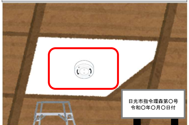
【施工中】高効率照明機器（調光型LED）
