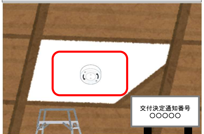
【施工中】高効率照明機器（調光型LED）
