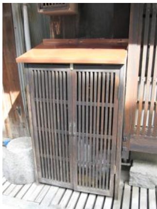
▲ゴミ置場が、中が見えないように街並みとの調和に配慮した素材で扉を設けた例
