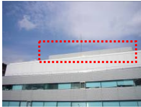
▲建物屋上に設置された設備関係をまとめて囲って意匠的に隠している事例
