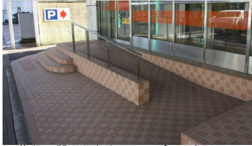
▲階段に設けられたスロープ・手すり
