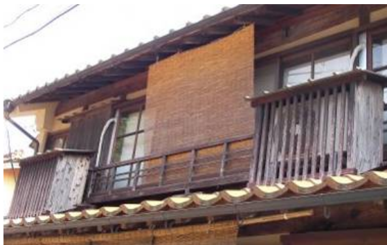
▲室外機が建物と調和したデザインの柵に覆われている例
