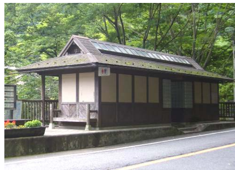
▲木材と新建材を組み合わせた建物
