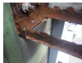
底部が腐食していた看板の例
