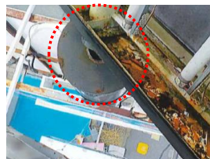
鉄骨接合部（プレート）が破損している状態
