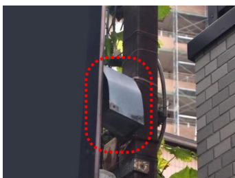
ブラケット・取付部の腐食（ブラケットカバー外れ）
