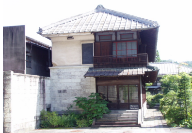
小林邸 石張りとはり壁の 合築
