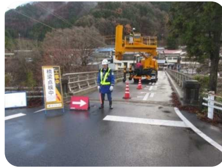
写真 3-1 定期点検の状況
