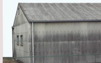
アスベスト含有スレート波板 (工場の屋根・壁)
