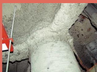
吹付けアスベスト (鉄骨材の耐火被覆)
