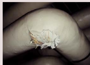
アスベスト保温材 (配管の断熱被覆)
