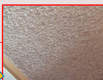
吹付けパーミキュライト (天井の断熱・吸音)
