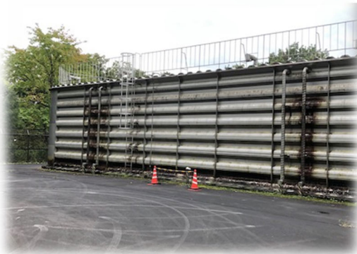
小倉山配水池 災害用給水栓
