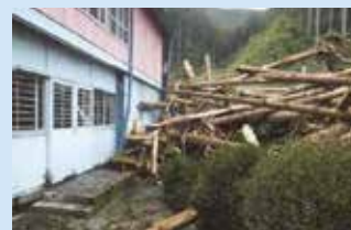
▲土砂災害の様子(鹿沼市下粕尾 学校沢)
