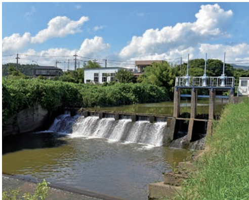
↑桜川堰跡（茨城県桜川市）
