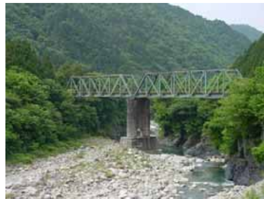
16-5 . 足尾鉄道 第二渡良瀬川橋梁
