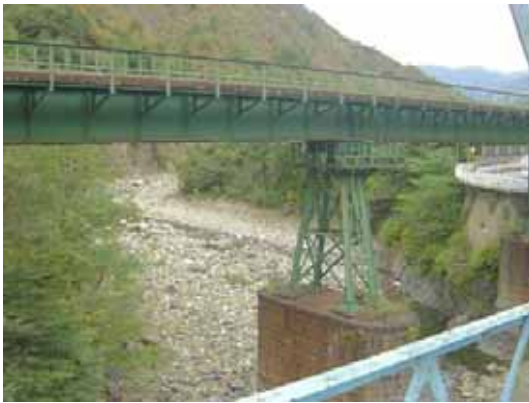
16-2 . 足尾鉄道 第一松木川橋梁
