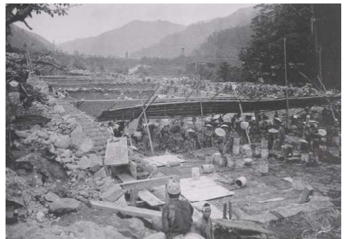
中才浄水場建設工事
