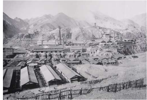
脱硫酸設置後の本山製錬所
