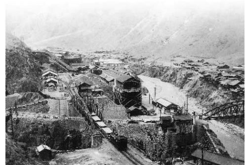
足尾鉄道（本山駅付近）
