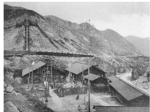
明治28年頃の間藤水力発電所
