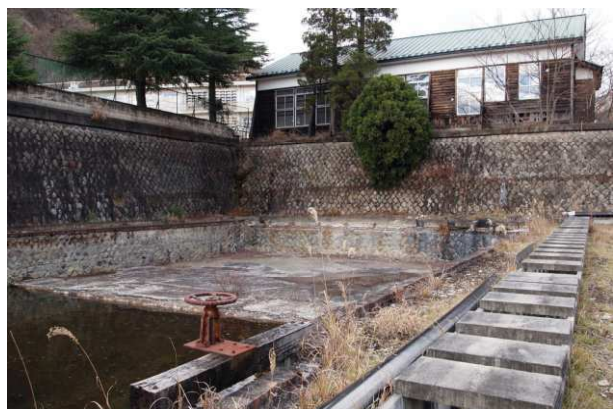
間藤浄水場（第1号沈殿池と旧本山小学校講堂）
