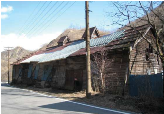
本山動力所跡（建屋仮設工事完了時）
