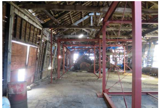
建屋内部の仮設補強の設置状況
