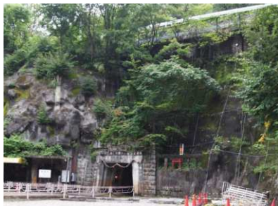
坑口上部の防護ネット・樹木
