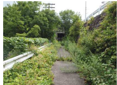
通洞坑上部（通路）
