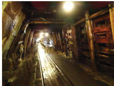
通洞坑内部（坑道奥から坑口方面を撮影）
