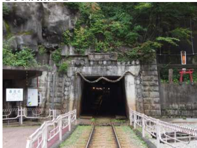
通洞坑坑口部分（左：説明板）
