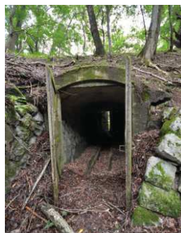
第三号庫（隧道部分）
