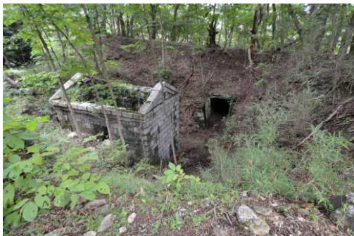
第一号庫（全景）
