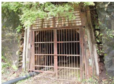
本山坑坑口部分
