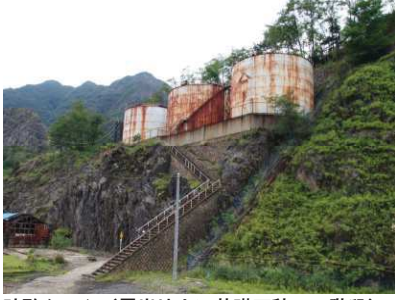
硫酸タンク（露岩地上に基礎石積み・階段）
