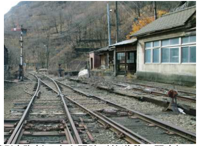
本山駅跡（軌道敷・駅舎）
