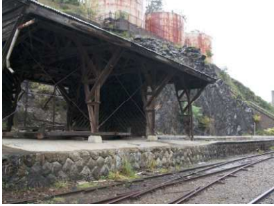
本山駅倉庫とプラットホーム
