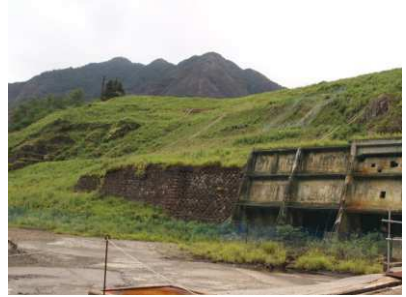
斜面地（法面保護の状況）
