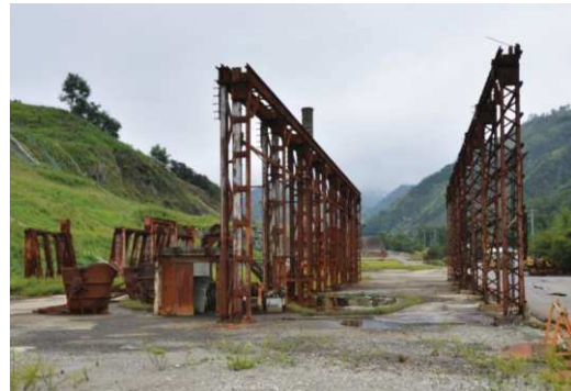
クレーン柱・自熔炉フレーム
