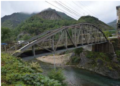
重要文化財古河橋
