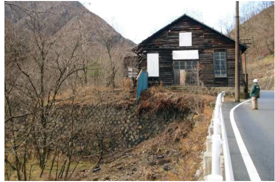
敷地を囲む石積（右は市道、左は出川）
