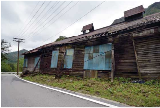
本山動力所跡 建屋外観
