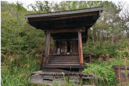
本殿及び本殿背後の斜面林
