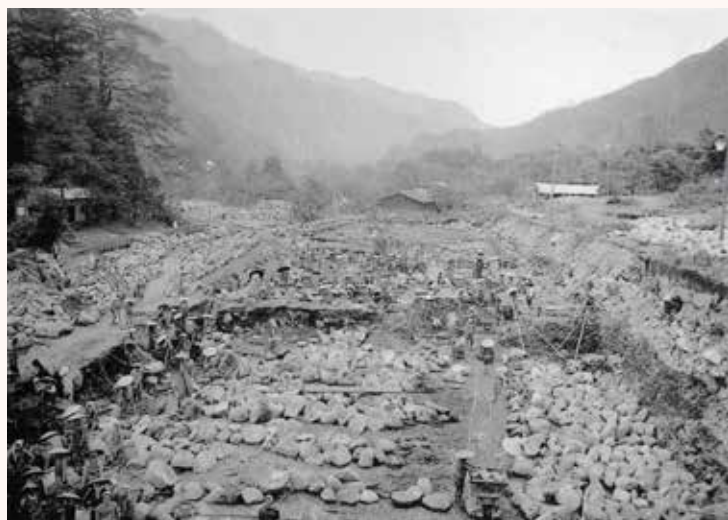
↑建造中の中才中段の沈殿池（明治30年7月）
