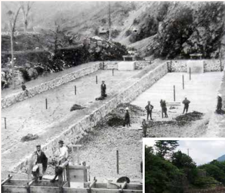
↑ 建造中の向間藤濾過池（明治 30 年 7 月）
