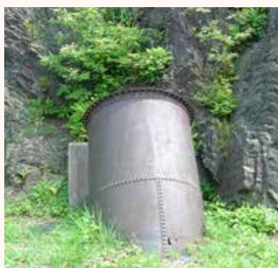
↑ 現存する間藤水力発電所の水圧管
