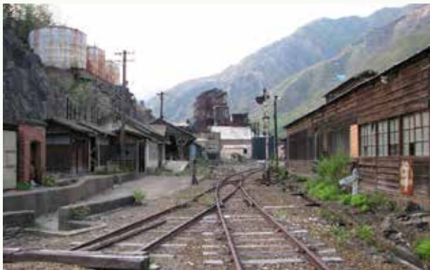
↑旧足尾鉄道足尾本山駅から製錬所を望む
