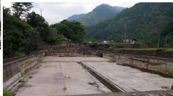
↑ 現在の向間藤濾過池
