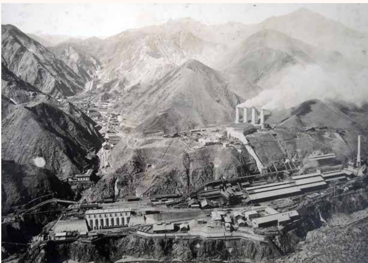
↑大正4年に完成した鋳煙処理施設（上）と大正5年頃の本山製錬所（下）
