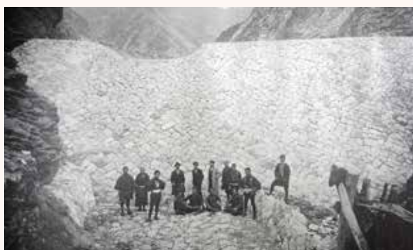
↑上段 建造中の本口沢の砂防堰堤（明治30年11月）
