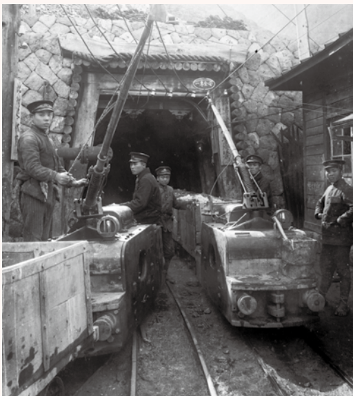
↑有木坑口とトローリー式坑内電気機関車(大正7年頃)
