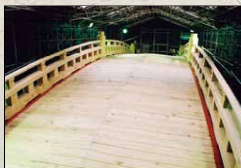
神橋の保存修理 木部組立(平成12年度)
