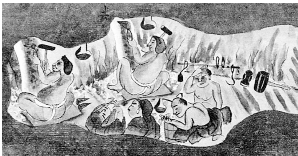
図-13 抜き掘り（手掘り）の様子
