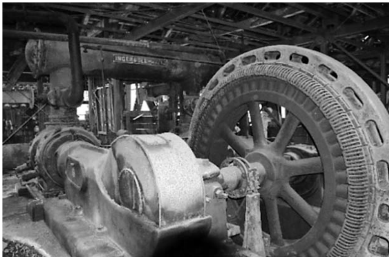
写真－23 4号機 (PE- 2) 電動回転子
