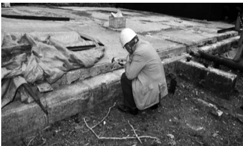
写真－ 16 基礎コンクリートの目視及び打音調査
