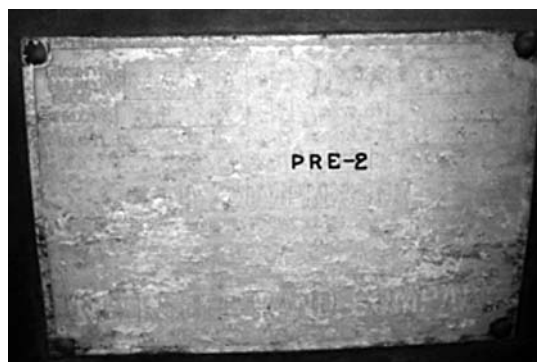
写真-11 8号機の銘板の確認状況
