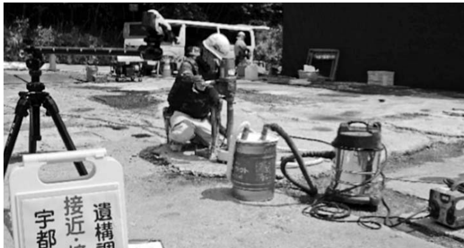
写真－ 19 コア抜き作業
