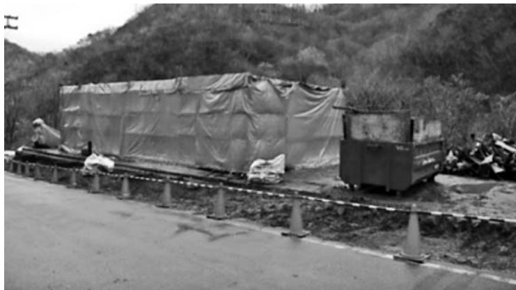
写真－14 解体直後の様子
