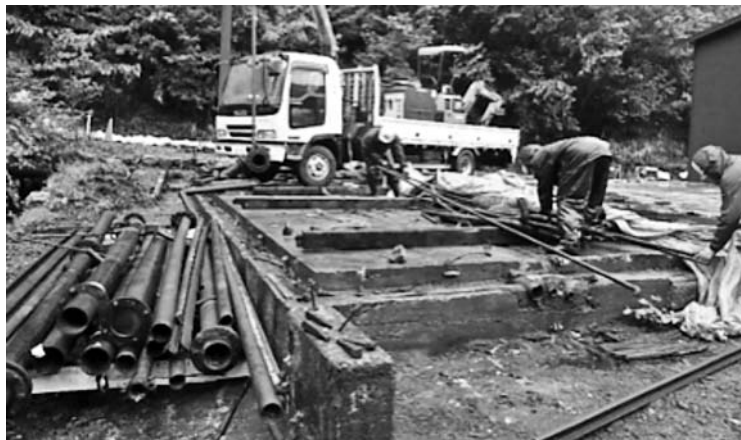
写真－13 本山動力所内鉄管の取り纏め作業
