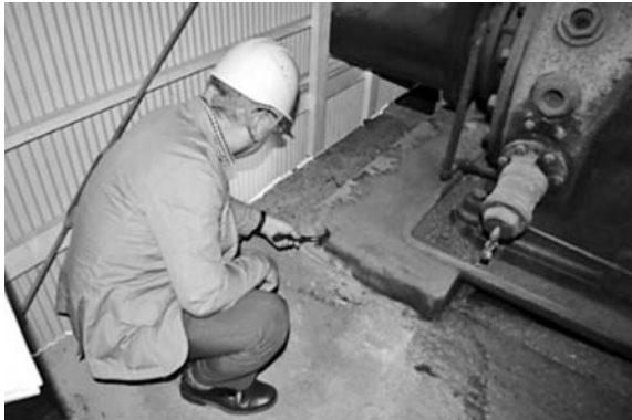
写真－ 17 圧気機基礎の目視及び打音調査
