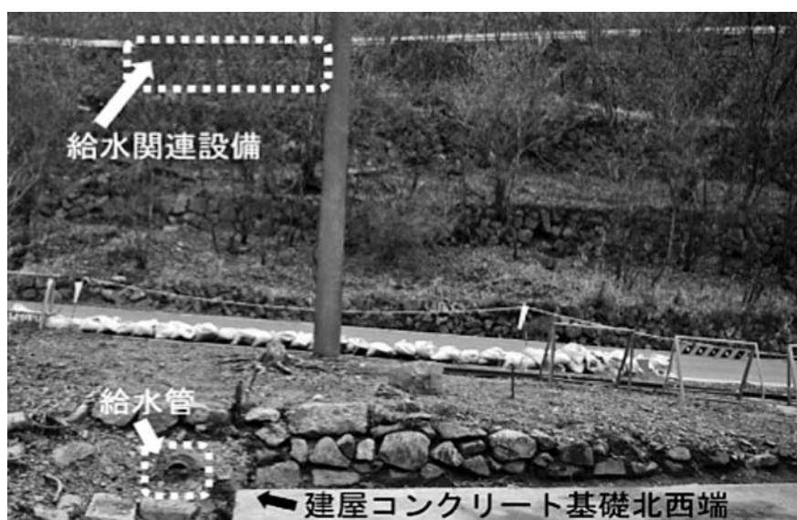
写真－ 34 その他の給水関連設備
