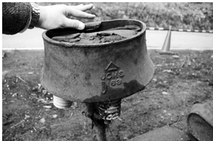
写真- 27 電力を引き込むための受電設備
