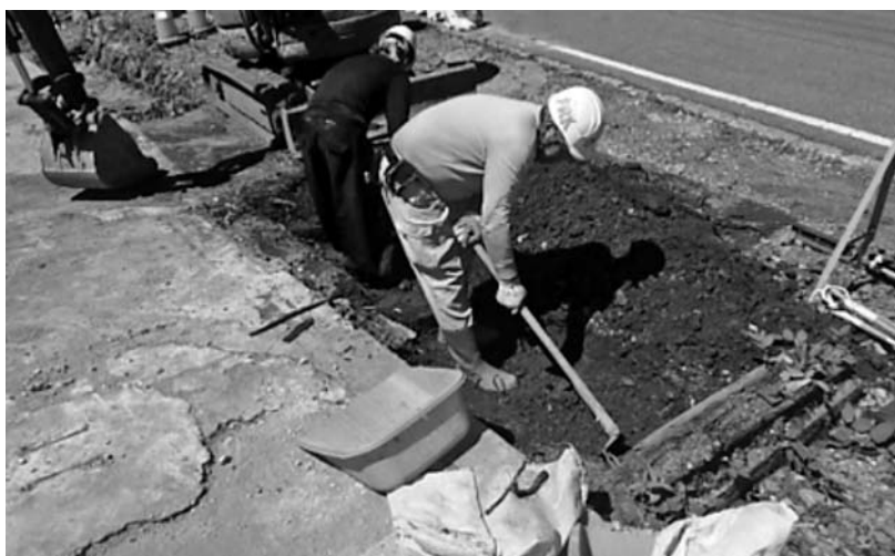
写真－ 15 基礎の埋没部分の掘り出し作業
