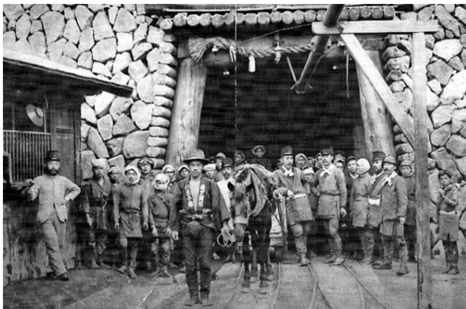
写真－２ 本山坑内から坑外への軌道の例（馬） [7]
