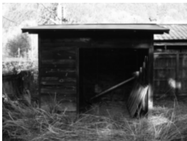
写真29 倉庫（19号） 南から
