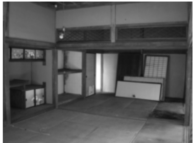
写真12 19号接客棟座敷
