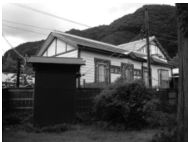
写真28 変電施設建屋（12号） 西から
