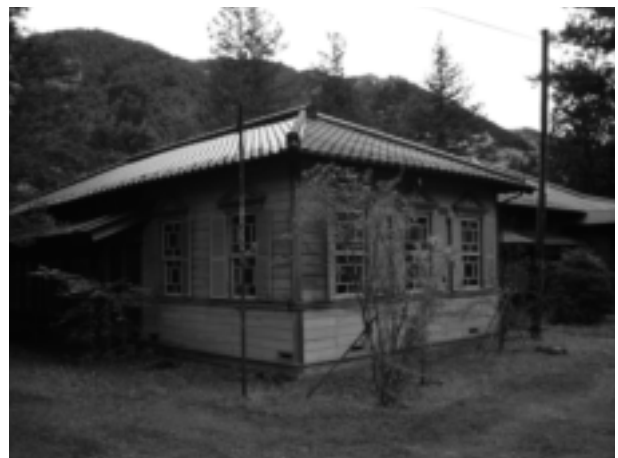
写真6 20号洋風応接室 北から
