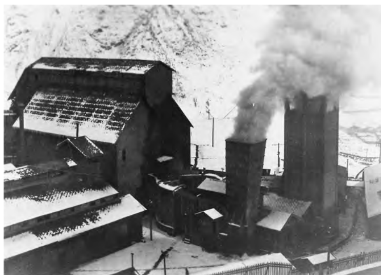
写真6 電気集塵を行っていない排ガス（昭和2年2月6日） 右側煙突頂部の陣笠も見えない程の煤塵濃度である
