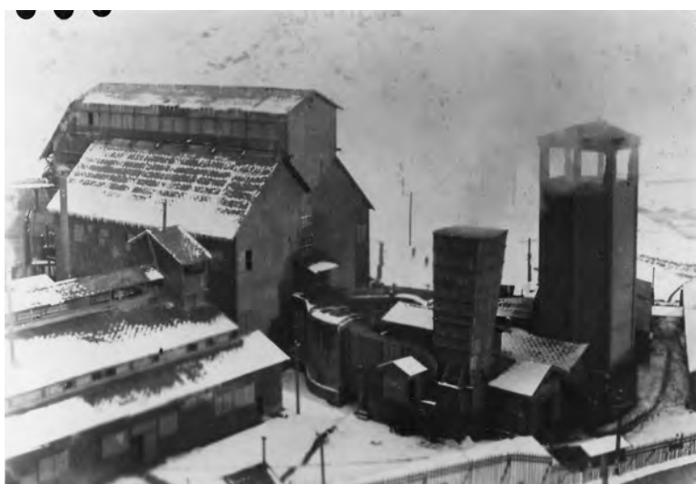
写真7 電気集塵を行っている排ガス（日付、同前） 煤塵濃度が低く、雪景色の背景の山肌も見えている
