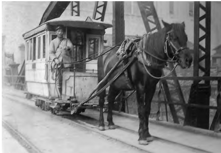
定時馬車今ヤ本山(古川橋)鉄橋ヲ発セントス。
